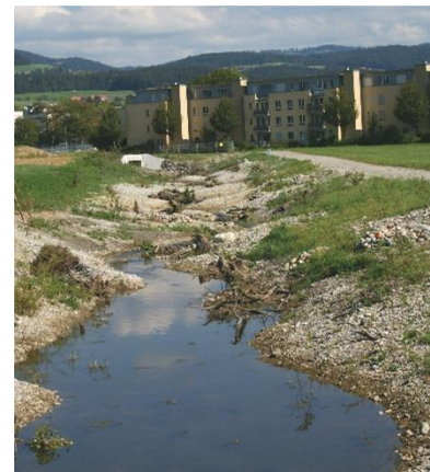
Abb. 7: Der offengelegte Grabebach im Sommer 2009. Im Hintergrund der Austritt aus dem neuen Betonkanal.
